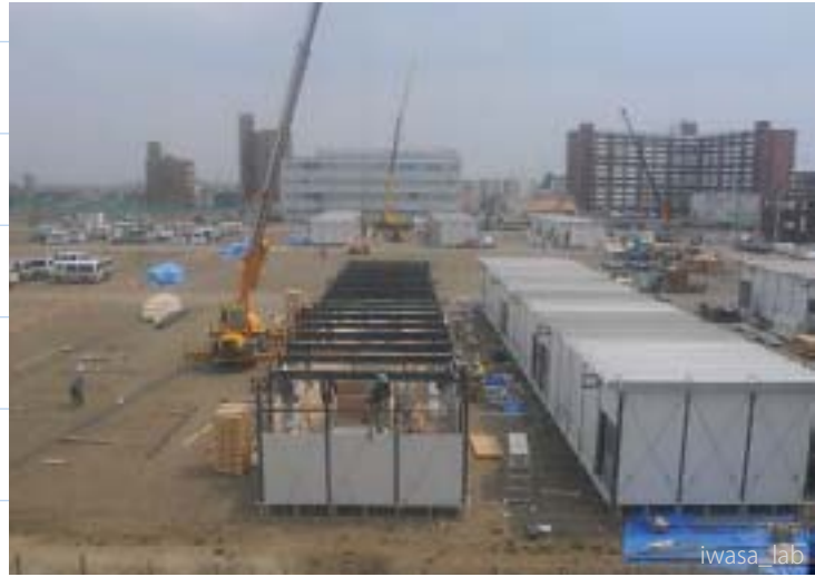
仮設住宅の建設の様子
