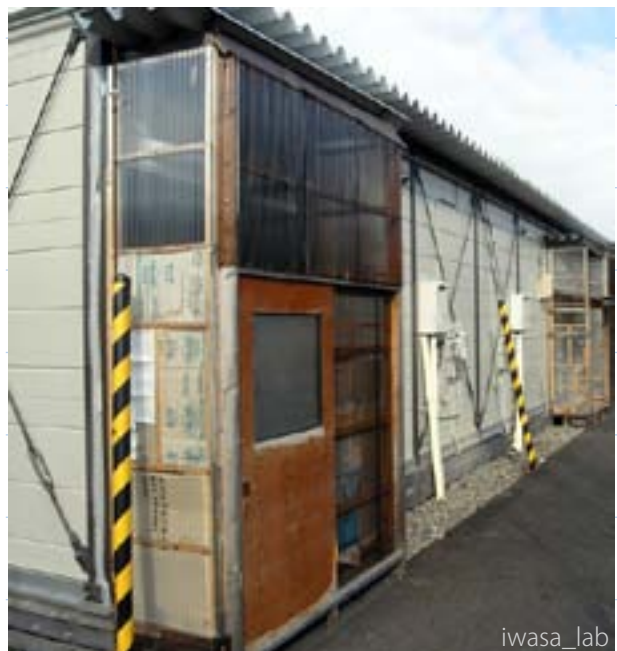
iwasa_lab 木材、波板、雨樋で風除室
